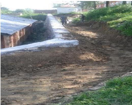
Figure 8 सेवा लिन जाने बाटो छालिङ्ग अपाङ्गता मैत्री बनाउदै
